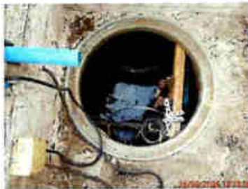
บ่อพักน้ำหลังผ่านระบบบำบัดน้ำเสียของอาคารที่พักผู้โดยสาร ชุดที่ 2
